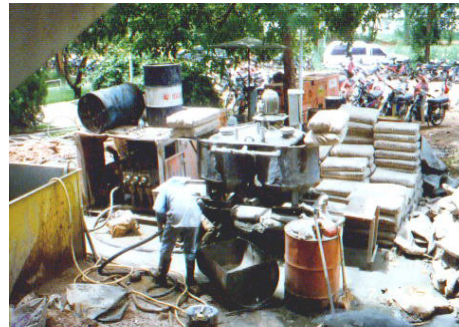
รูปที่ 3 (ค) แสดงการซ่อมแซมการทรุดตัวของอาคารคณะมนุษยศาสตร์ฯ โดยวิธีการอัดน้ำปูนใต้ฐานราก (17)
