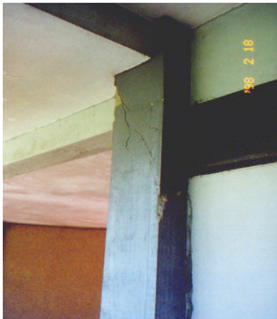
รูปที่ 3 (ข) แสดงรอยแตกร้าวจากการทรุดตัวของฐานรากของแฟลตร่มรื่น (1)
