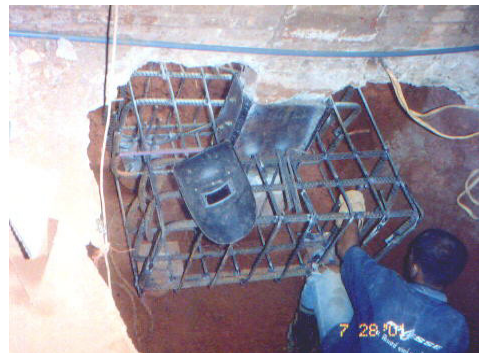
รูปที่ 3 (ง) แสดงการซ่อมแซมการทรุดตัวของหอพักที่ 7 โดยวิธีเสริมฐานรากด้วยเสาเข็มขนาดเล็ก (17)
