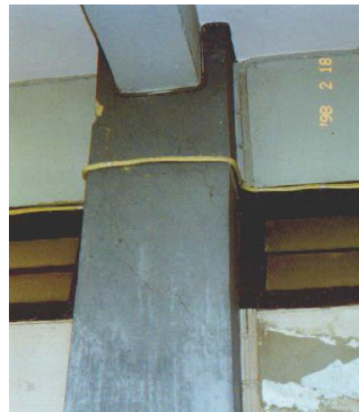
รูปที่ 3 (ข) แสดงรอยแตกร้าวจากการทรุดตัวของฐานรากของแฟลตร่มรื่น (1)
