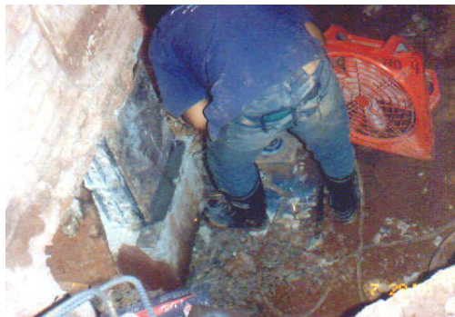
รูปที่ 3 (ง) แสดงการซ่อมแซมการทรุดตัวของหอพักที่ 7 โดยวิธีเสริมฐานรากด้วยเสาเข็มขนาดเล็ก (17)
