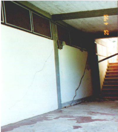
รูปที่ 3 (ก) แสดงรอยแตกร้าวจากการทรุดตัวของฐานรากของแฟลตเขียวจี (1)
