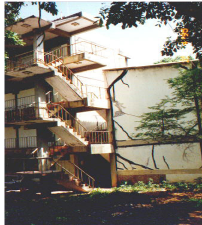
รูปที่ 3 (ก) แสดงรอยแตกร้าวจากการทรุดตัวของฐานรากของแฟลตเขียวจี (1)
