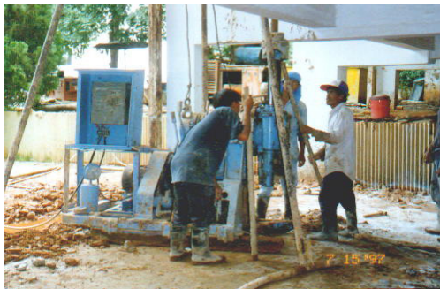
รูปที่ 3 (ค) แสดงการซ่อมแซมการทรุดตัวของอาคารคณะมนุษยศาสตร์ฯ โดยวิธีการอัดน้ำปูนใต้ฐานราก (17)
